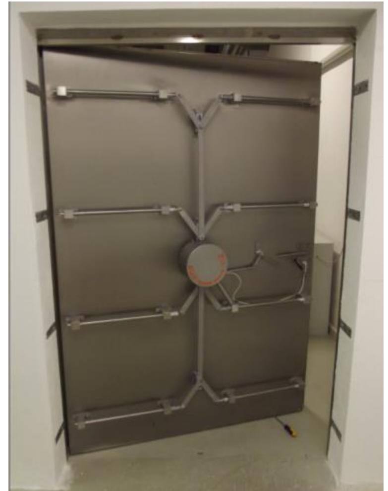
Bild: Ansicht Hochsicherheitstür (RC4/6)
