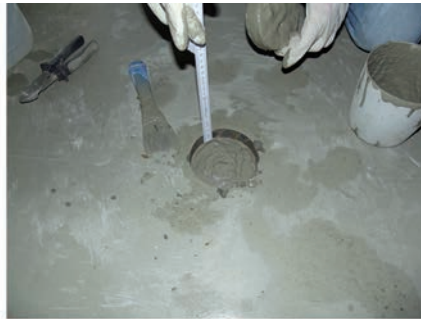
Bild 4 Sensor montage im Fugenbereich
