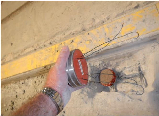
Bild 7 Sensormontage in Instandsetzungsstelle
