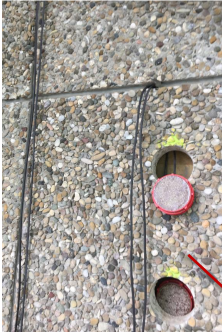
Abfragestelle vor Fertigstellung
