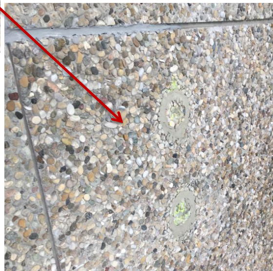
Abfragestelle nach Fertigstellung
